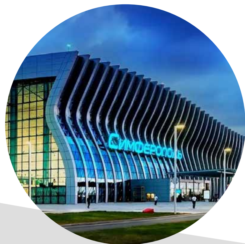
Аэровокзальный комплекс аэропорта Симферополь
